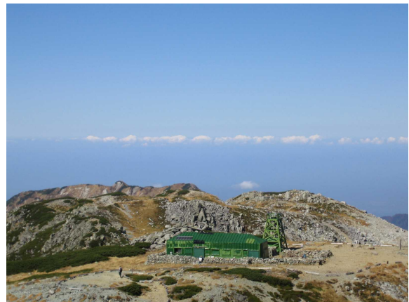
写真2：富山大学立山施設（浄土山）
