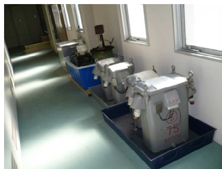
■ 大型PCB廃棄物の保管状況
