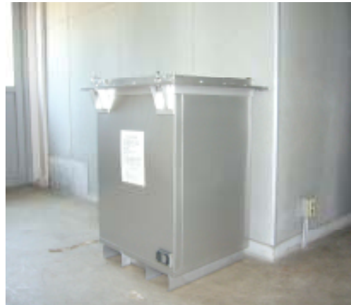
変圧器保管容器
