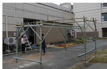
仮設構造物の建設
