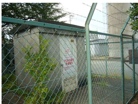
PCB 廃棄物保管倉庫
