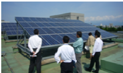
太陽光発電設備
