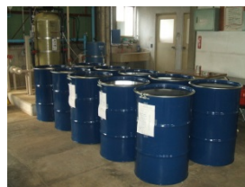
PCB含有安定器を保管している処理施設指定容器
