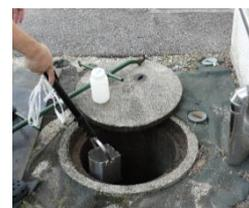
実験系排水の採水の様子
