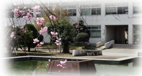
五福キャンパス 工学部共通研究棟
