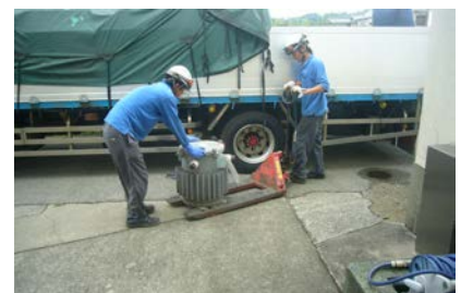
低濃度 PCB 廃棄物払出作業 （五艘地区）
