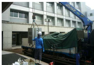
低濃度 PCB 廃棄物払出作業 （五福地区）
