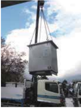
低濃度 PCB 払出し作業風景
