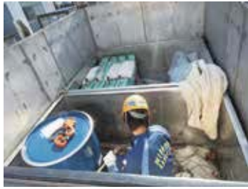
高濃度 PCB 払出し作業風景
